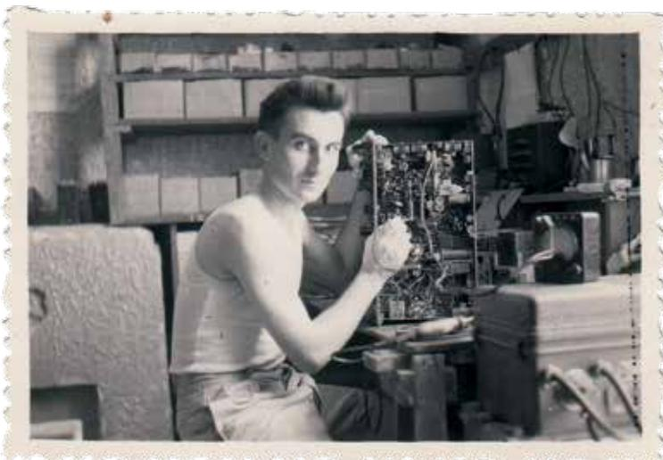
La maintenance des appareils représentait une autre difficulté car ces derniers nécessitaient un renouvellement fréquent de certaines de leurs pièces. Fonctionnant à l'aide de génératrice à main (GN.58) pour l'émission et par piles pour le SCR 300 (BA70) et (BA48) pour le récepteur SCR 694, le ravitaillement était aussi le souci de chaque mois : 1 tonne de piles, des myriades de lampes, condensateurs et résistances à ramener de Haïphong en traversant de bien traîtresses difficultés...
