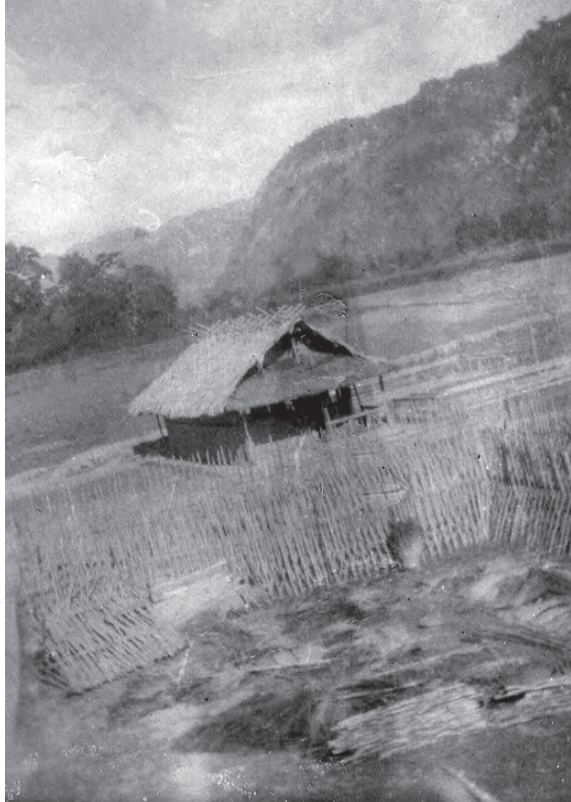
Reconstruction du poste de Suyut.
